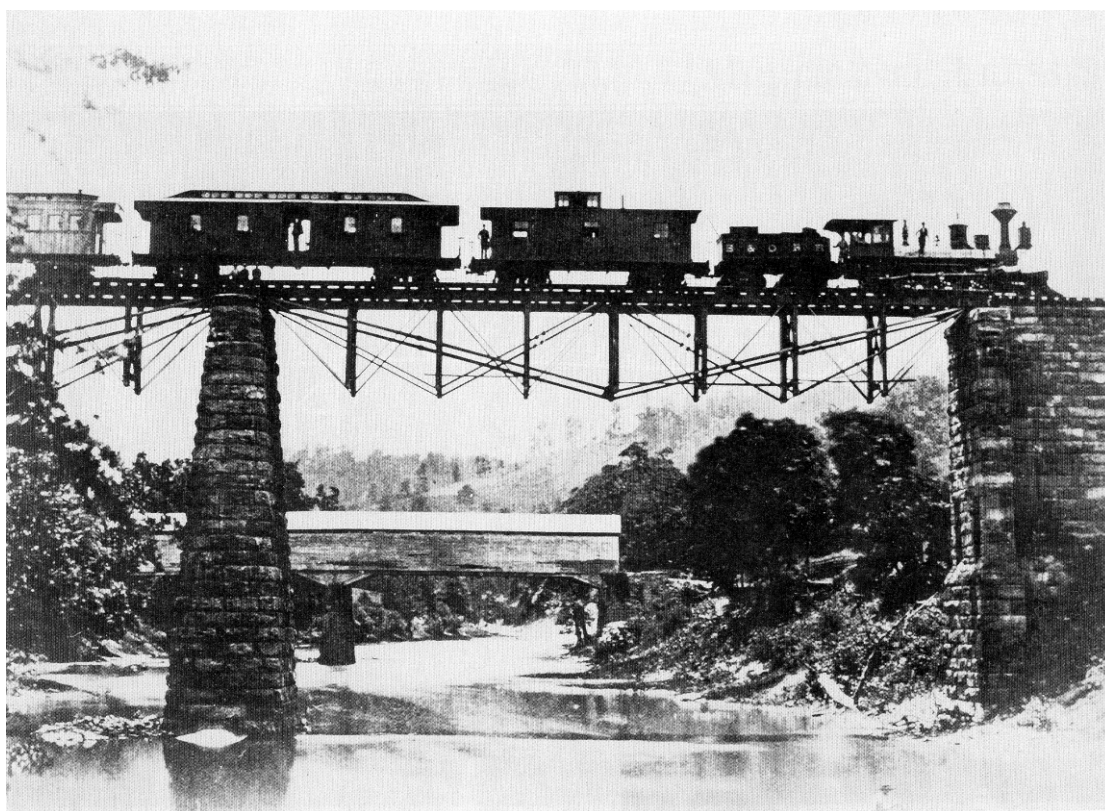
Σχήμα 10. Μεταλλική Σιδηροδρομική Γέφυρα με σύστημα αντώσεως
