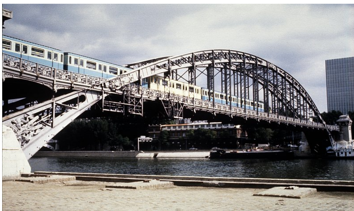
Σχήμα 8. Τριαρθρωτό Τόξο ως σχοινοειδής φορέας για τα αναρτημένα φορτία σχεδιασμένο από τον Gustav Eiffel με την μορφή ανεστραμμένης αλυσοειδούς καμπύλης
