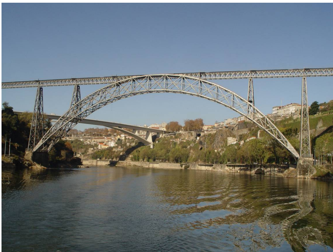
Σχήμα 9. Σιδηροδρομική γέφυρα «Μαρία Πία» στο Πόρτο της Πορτογαλίας
