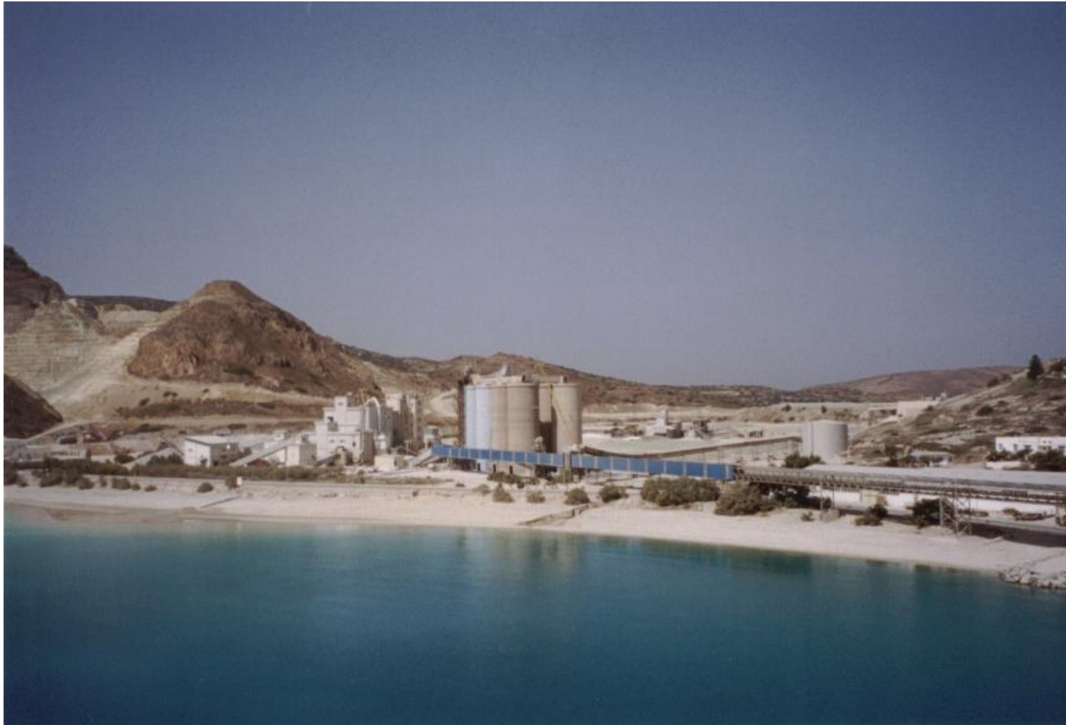
Μήλος: εγκατάσταση επεξεργασίας μπεντονίτη
