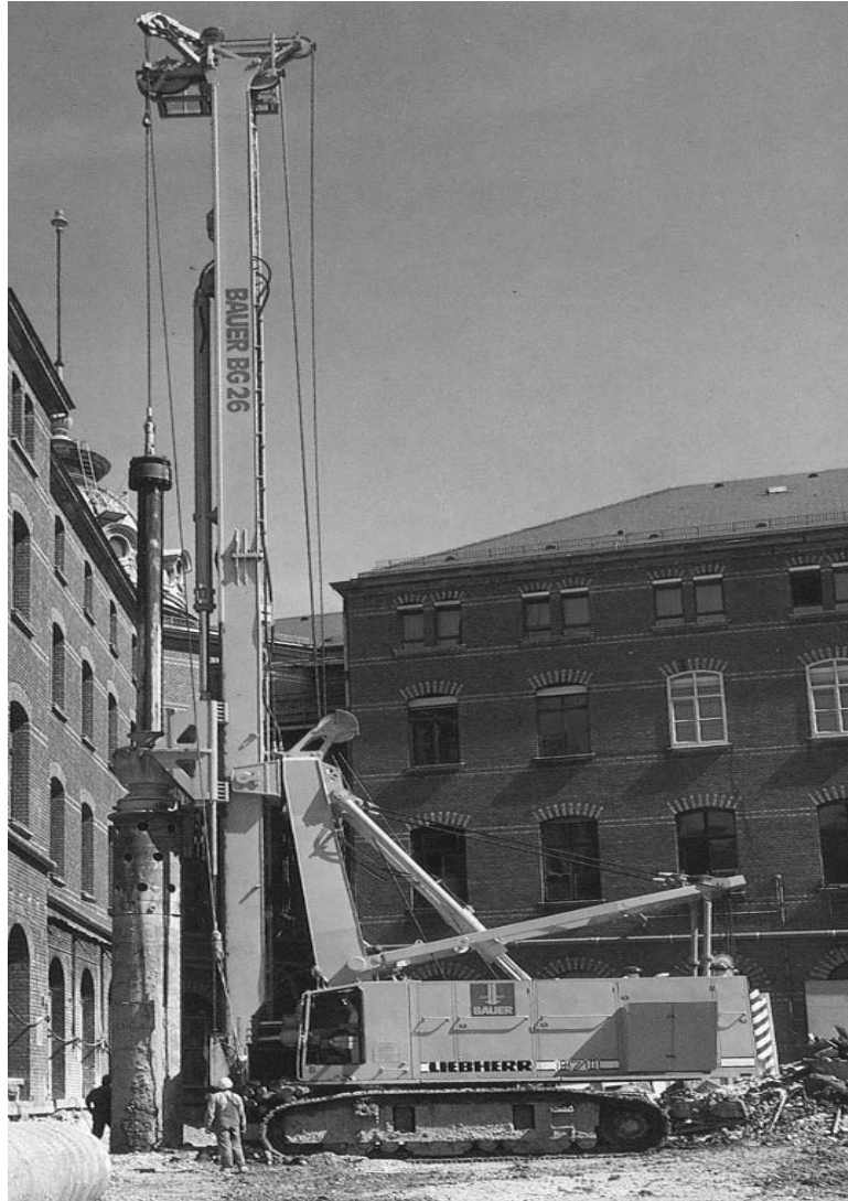
Κατασκευή συνήθων εγχύτων πασσάλων
