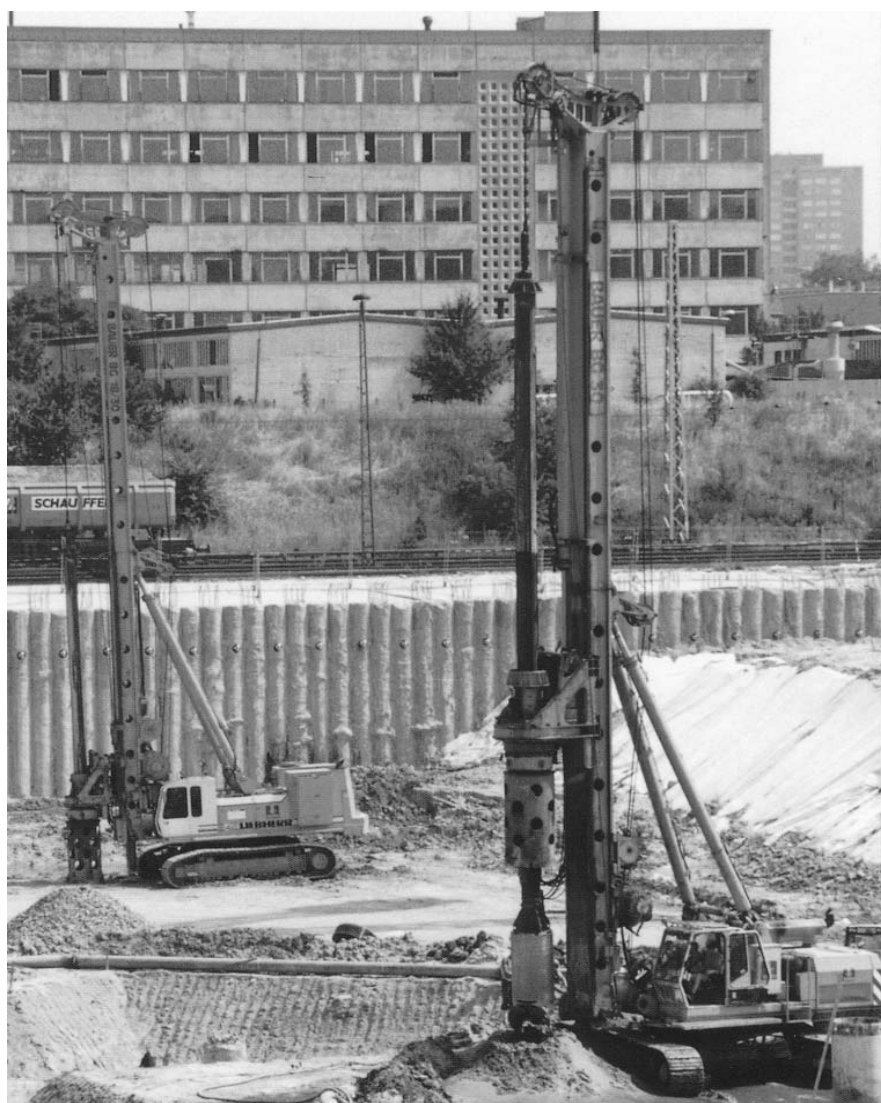
Κατασκευή συνήθων εγχύτων πασσάλων
