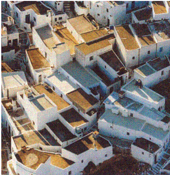
Εικ.13. Στέγαση με δώμα.
