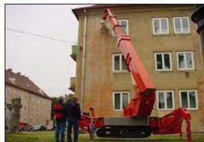
(δ) Μηχάνημα βαφής πολυώροφου κτιρίου
