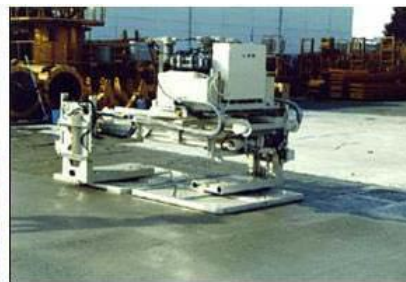
(β) Ρομπότ κατασκευής βιομηχ. δαπέδων
