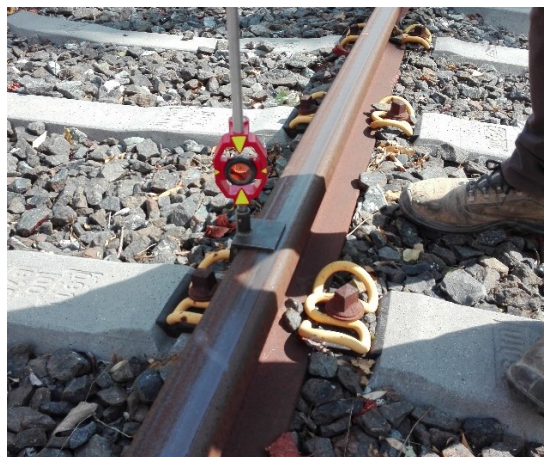
Εικόνα 3. Αποτύπωση σιδηροτροχιών με τη μέθοδο των γωνιών
