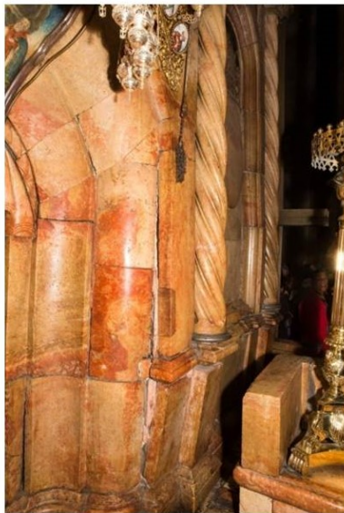
Εικόνα 3: Διόγκωση της τοιχοποιίας στην ανατολική όψη του μνημείου [Moropoulou et al, 2017]
