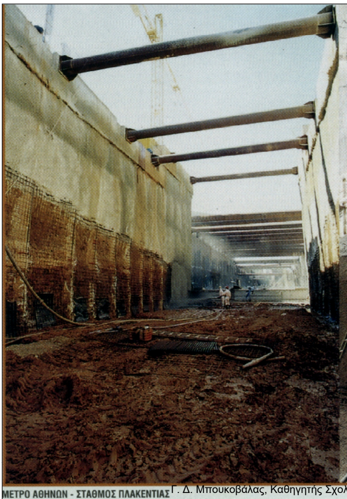
ΜΕΤΡΟ ΑΘΗΝΩΝ - ΣΤΑΘΜΟΣ ΠΛΑΚΕΝΤΙΑΣ
