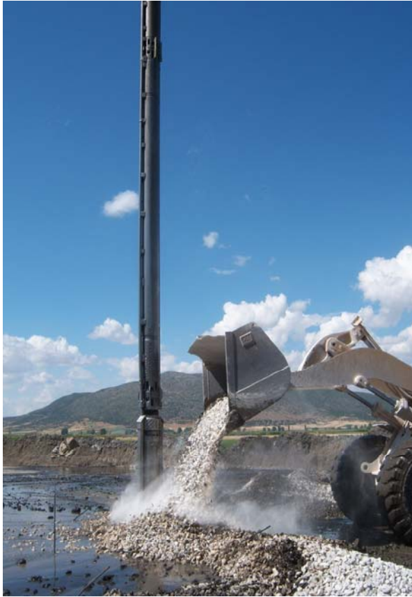
ΧΑΛΙΚΟΠΑΣΣΑΛΟΙ ΣΤΗΝ Λ. ΞΥΝΙΑΔΑ (ΟΣΕ, 2008)
