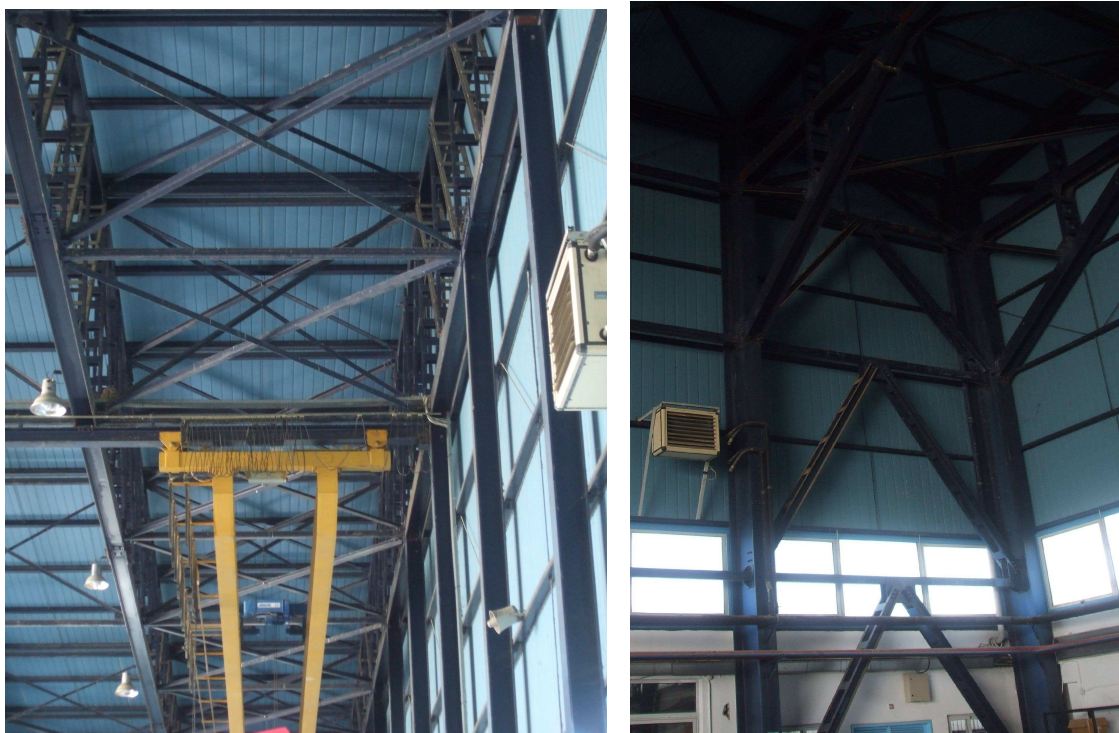
Φωτογραφίες 2.1 & 2.2: Οριζόντιοι και κατακόρυφοι σύνδεσμοι δυσκαμψίας
