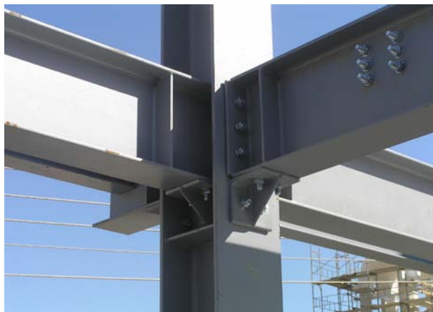
Σχήμα 5.15: Σύνδεση κύριας δοκού (IPE 400) με κύρια δοκό (IPE 370) και υποστύλωμα C1 UC254x254x107.
