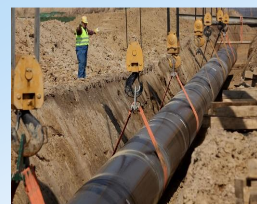
Τοποθέτηση αγωγού εντός ορύγματος. Lowering of pipe into trench.
