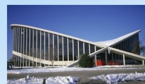
Dorton Arena, Βόρεια Καρολίνα, ΗΠΑ Dorton Arena, North Carolina, USA (1953)
