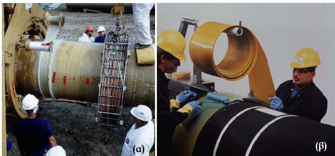
Σχήμα 4.11: Κατασκευή αγωγού CRLP (α) επί τόπου και (β) στο εργοστάσιο.
