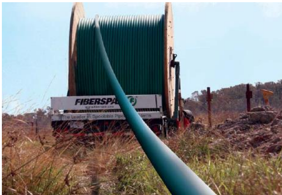
Σχήμα 5.4: Τρόπος μεταφοράς και τοποθέτησης υπέρ-εύκαμπτων αγωγών τύπου «Ξηράς».
