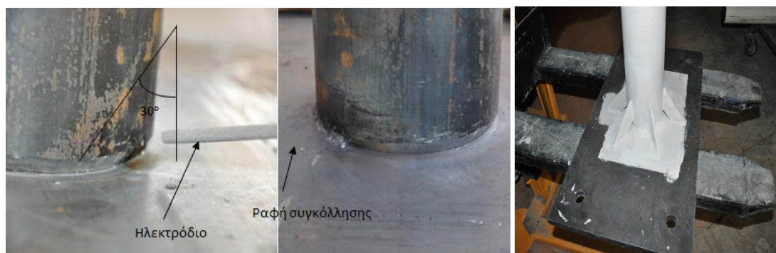
Εικόνα 3.1: Διαδικασία συγκόλλησης της κοιλοδοκού στην πλάκα έδρασης
