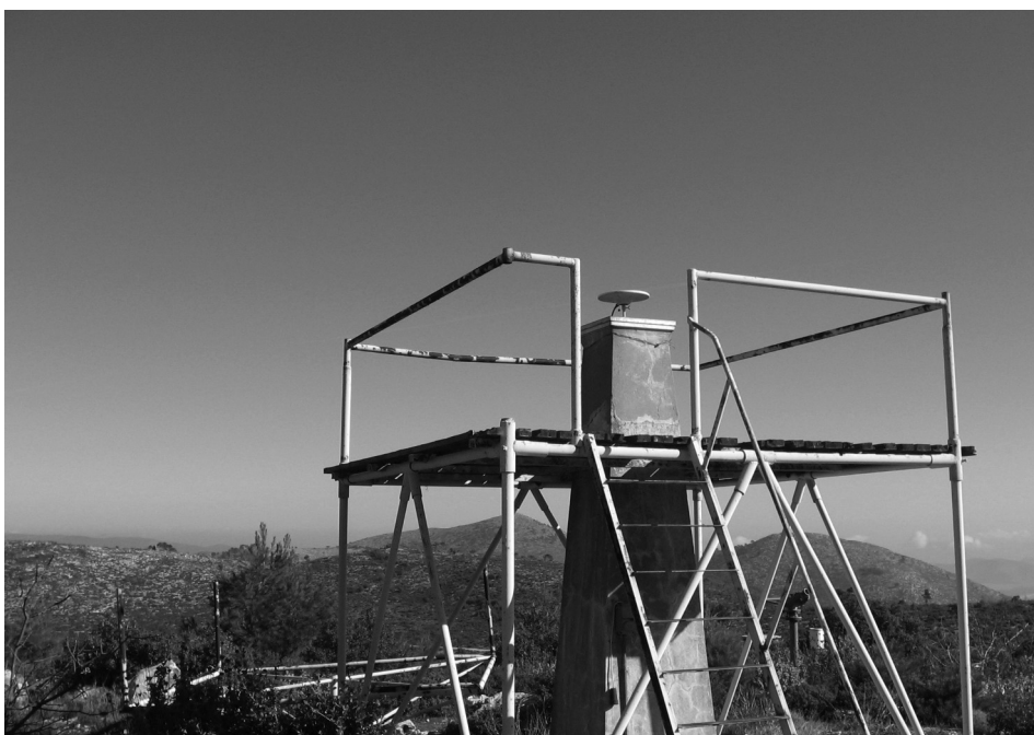
Εικόνα 10. Το βάθρο, στο Κέντρο Δορυφόρων Διονύσου του Εθνικού Μετσόβιου Πολυτεχνείου, αφηρηρία του Ελληνικού Γεωδαιτικού Συστήματος Αναφοράς του 1987. Πηγή: http://portal.survey.ntua.gr/main/labs/hgeod/DSO/DSOmain.htm
